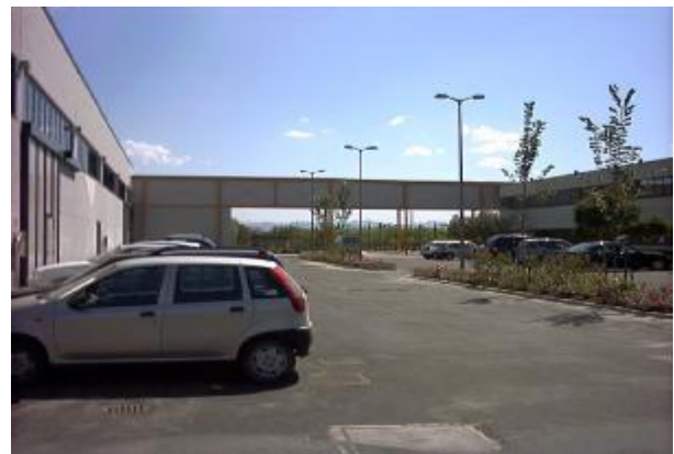
Figura 11 – Sullo sfondo si può vedere l'automazione che, coperta e sollevata da terra, trasporta i pezzi sospesi dalla verniciatura al magazzino spedizioni
