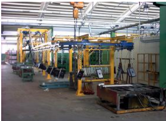
Figura 10 – Il reparto verniciatura con il nuovo impianto e in primo piano la catenaria
